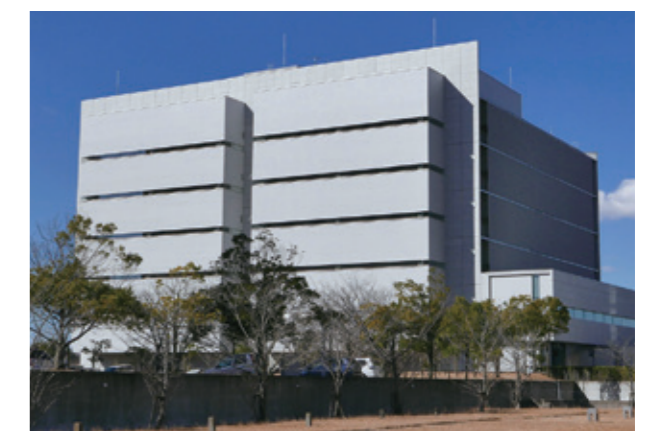
netXDC Chiba Center 2
