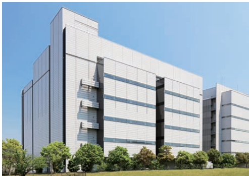
netXDC 千葉第3センター (S13)
