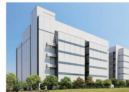
netXDC 千葉第3センター (S13)
